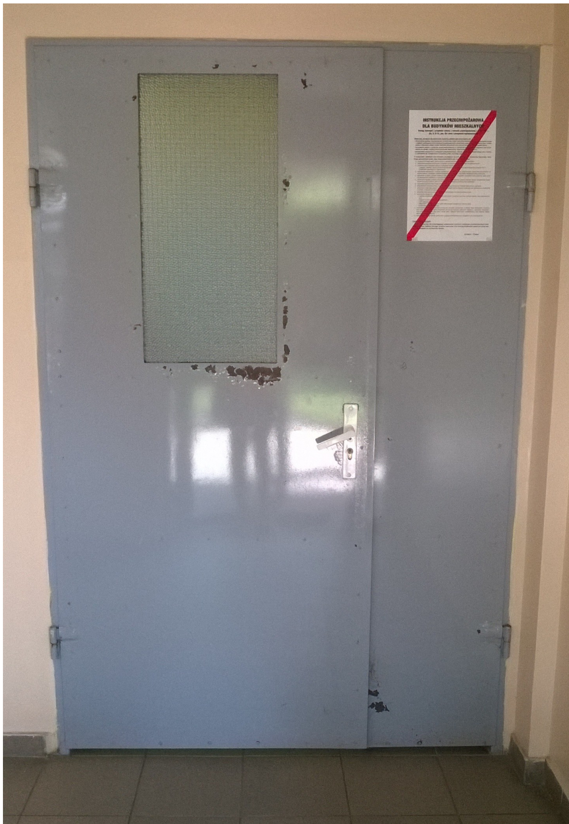
FOT. 1 Drzwi stalowe do demontażu
